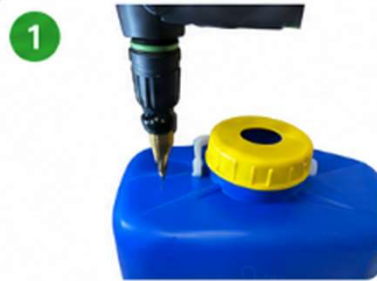
1 Perçage 22mm du réservoir avec un foret à étage
